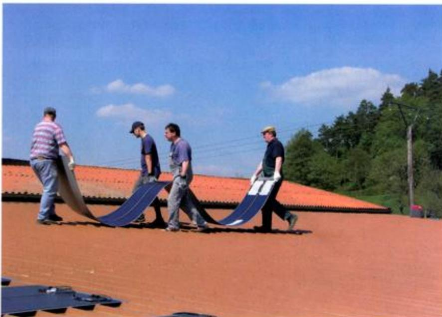
■ Im Bild die Montage von „Biosol PV Plate Dünnschicht-Laminaten“.
